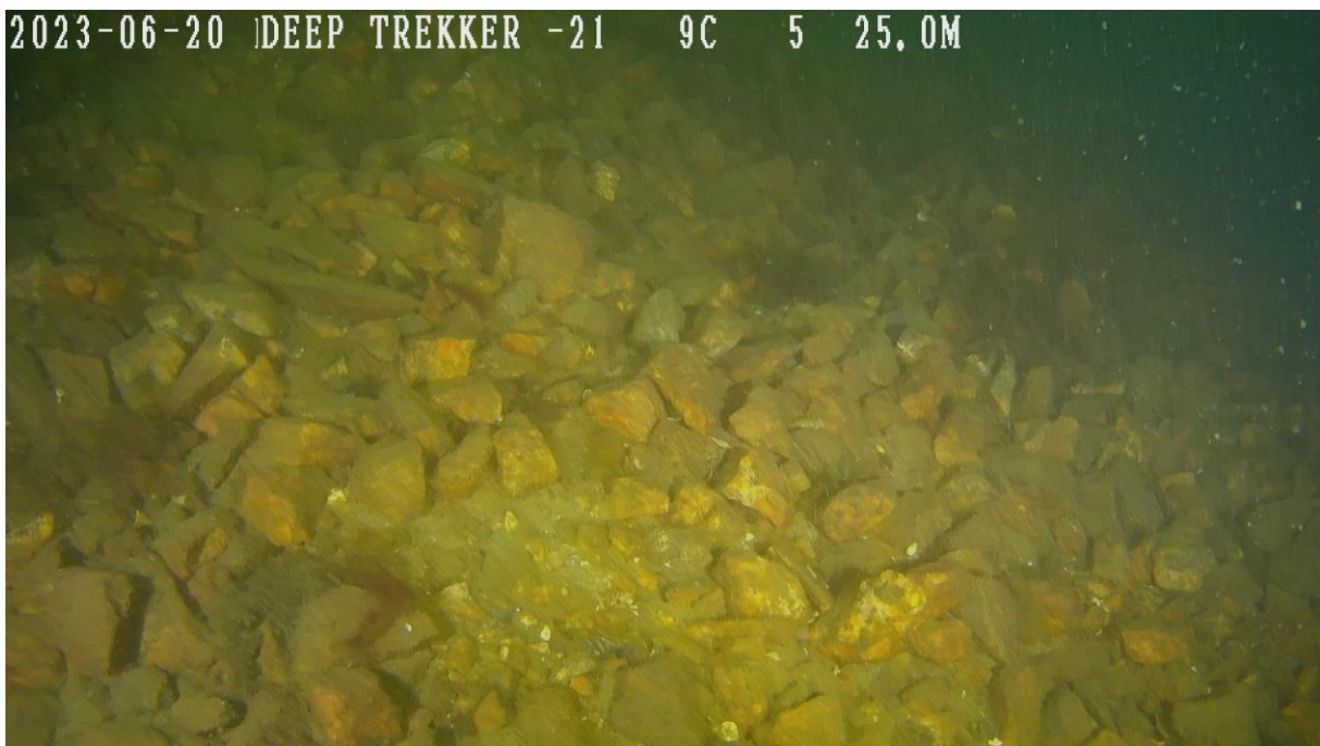
Figur 3.5. Intakt erosjonssikringslag bestående av grov pukk.
